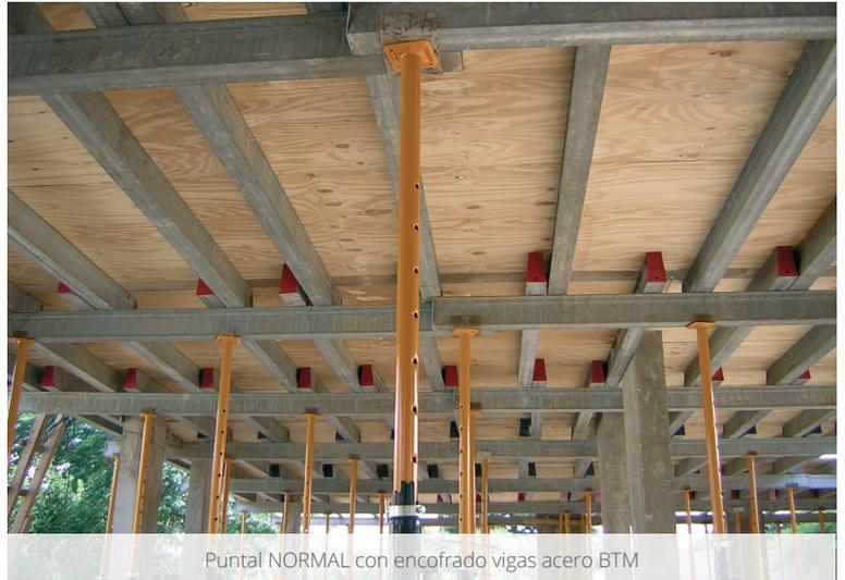
Puntal NORMAL con encofrado vigas acero BTM
