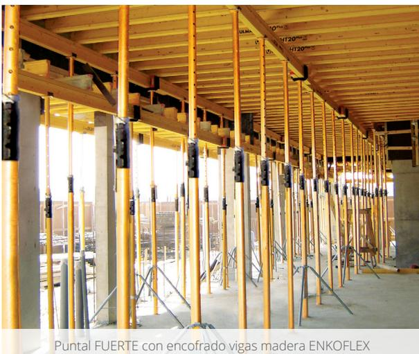
Puntal FUERTE con encofrado vigas madera ENKOFLEX
